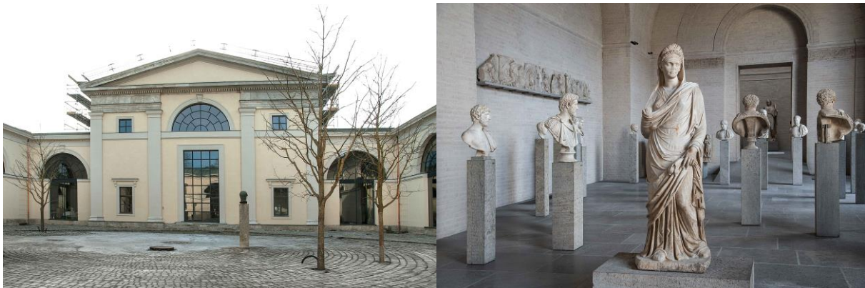
Glyptothek München, sanierte Innenhoffassade und Innenräume
